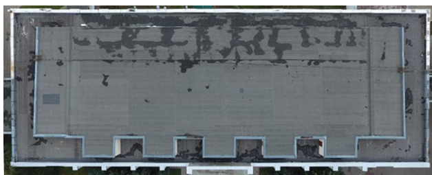
Рисунок 49 Результаты этапов АСТД ПРК: а – фотофиксации дефектов ПРК объекта апробации; б – сегментирования и нанесение цифровых моделей дефектов в ИМ ОС (дефекты ... /Def_8, ... /Def_9)
